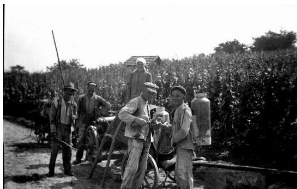
Links: Die ersten Rücken-Spritzen kamen zum Einsatz – und rechts: Der legendäre Erzinger Rebenvater Heinrich Winter, der stets sein Fässchen mit Reb-Spritz-Brühe, bestehend aus einem Kupferviteriol/Kalk/Gemisch, nebst Rückenspritze, auf einem von seinem Pferd „Lotte“ gezogenen „Spritzenwagen“ zum Rebberg transportierte.
