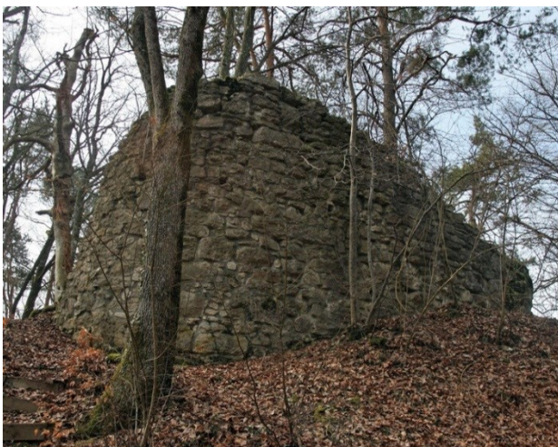
Einer der wenigen Mauerreste der Burgruine
